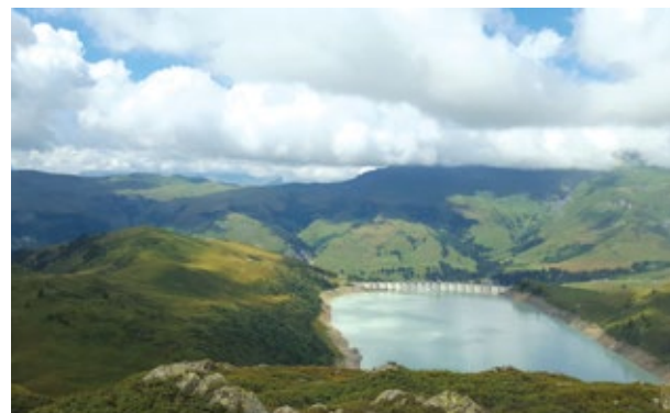
Construit entre 1942 et 1949, le barrage savoyard de la Girotte, profond de 134 mètres (50 millions de m 3 d'eau retenue), alimente sept centrales électriques.
